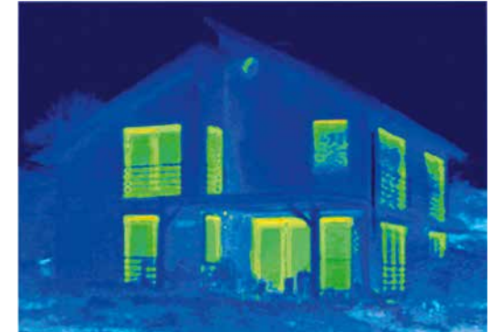
Na de zorgvuldige inbouw van nieuwe ramen uit het Schüco LivIng raamsysteem toont de thermografie een heel ander beeld. Het oorspronkelijke energieverlies is praktisch volledig verdwenen. Het oorspronkelijke energieverlies wordt nagenoeg volledig weggewerkt.
